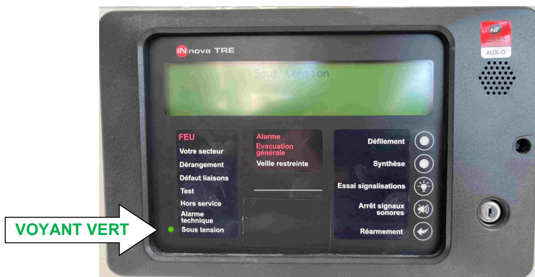
Figure 1 : le répétiteur état normal : seul un voyant vert signale qu'il est sous tension
