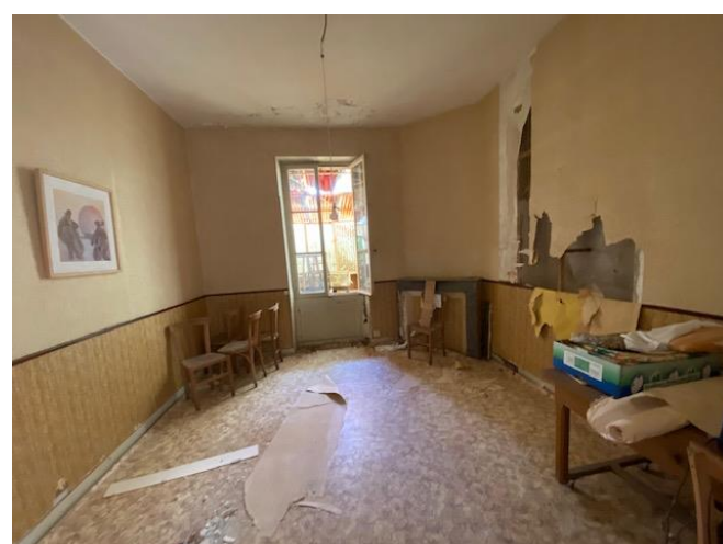
Les travaux de la future MAM
