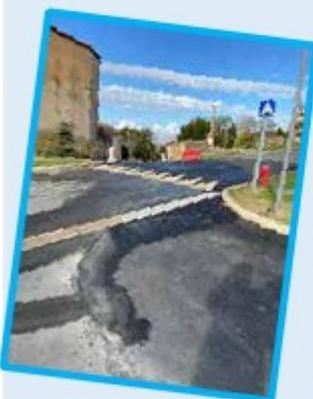
Un plateau rehausseur a été réalisé dans le bourg. Il permet de réduire la vitesse des véhicules qui traversent le bourg et facilite le passage des piétons pour la descente vers la cité Les Prés.
